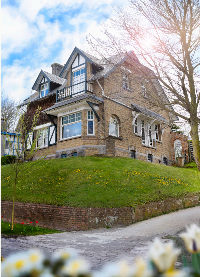
Een naburige villa, gerestaureerd volgens de oorspronkelijke technieken Une villa voisine restaurée selon les techniques d'origine
